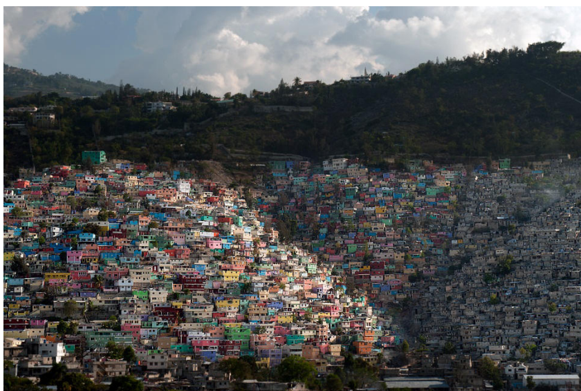
Wiederaufbau in Port-au-Prince; Foto Andrej Nowakowski
