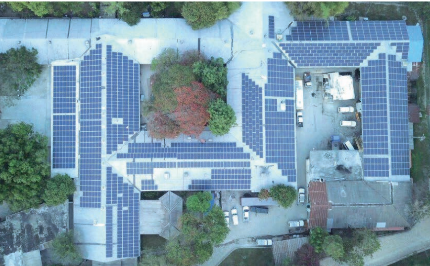
1550 Solarpanels liefern Strom für Spital und Campus!
