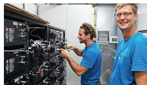
QINOUS Ingenieure montieren die 1024 Batterien.
