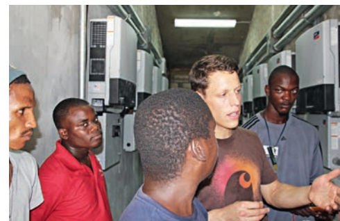
Marc Bättschmann trainiert die HAS Techniker im Inverterraum.
